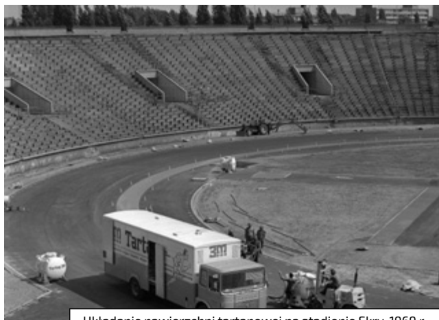
Układanie nawierzchni tartanowej na stadionie Skry, 1969 r.
